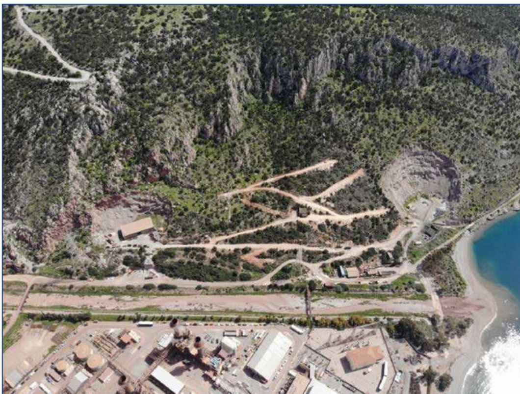
Σχήμα 8.3-1: Άποψη περιοχής ανάπτυξης νέου Σταθμού
