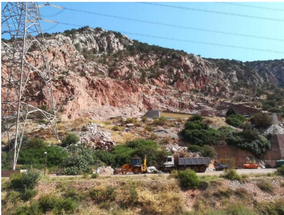
Θέση Φωτοληψίας 3: Χώρος εγκατάστασης πύργων ψύξης
