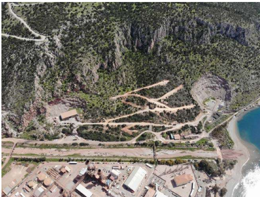
Σχήμα 6.1-1: Άποψη περιοχής ανάπτυξης νέου Σταθμού
